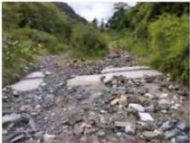
上流部洪水跡 9/12 12:05
