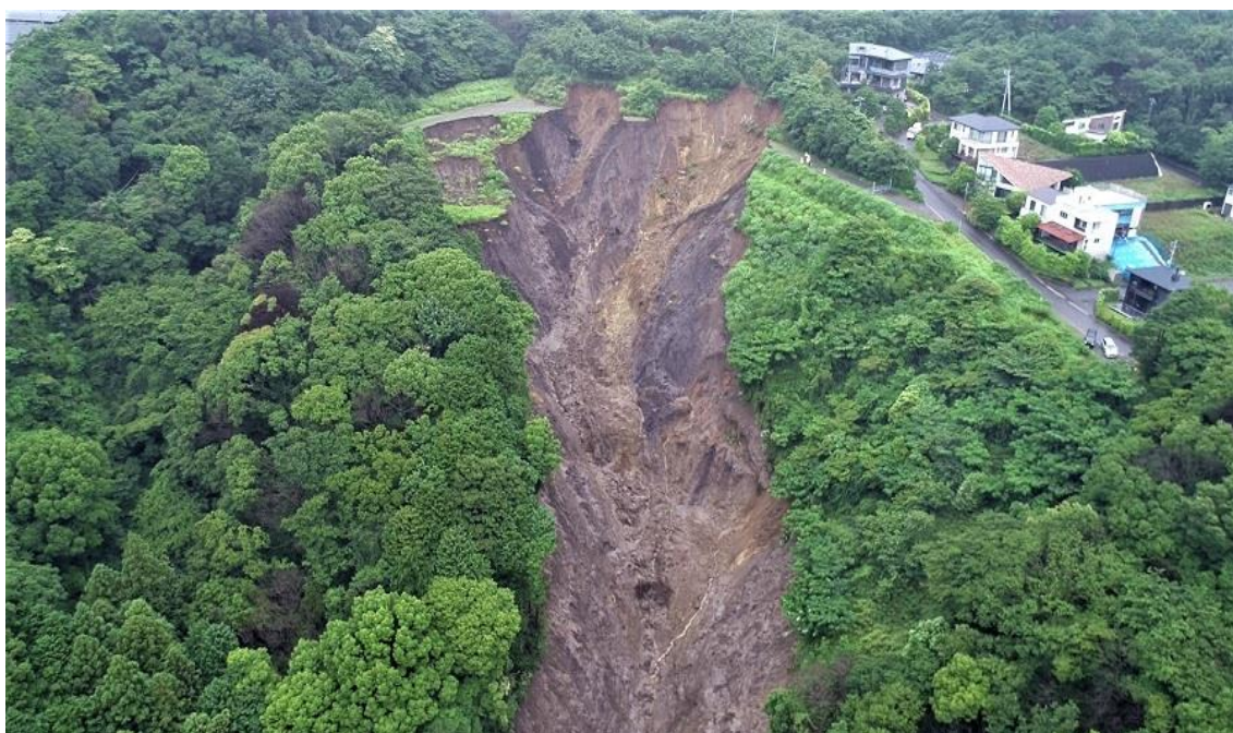
写真：土石流の起点となった廃棄物処分場崩落現場（熱海市 2021 年 7 月 3 日）
