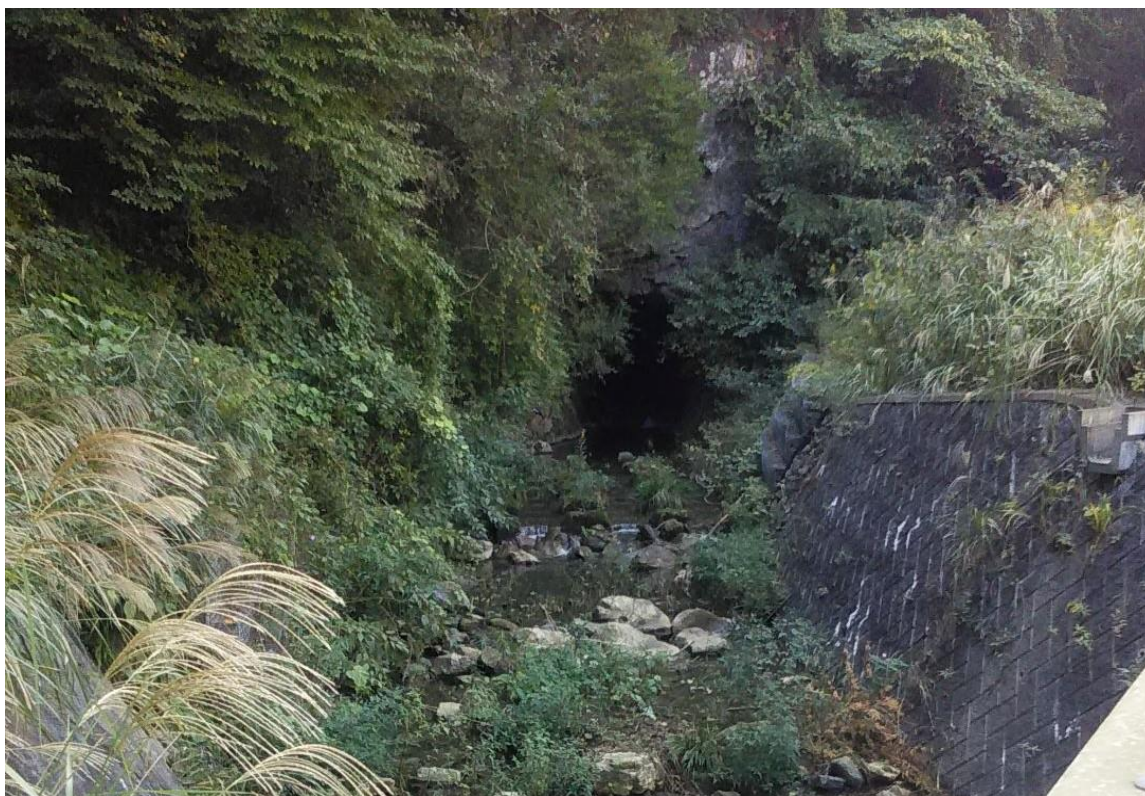
写真：鮎川本流の河川隧道(トンネル)の下流側出口
