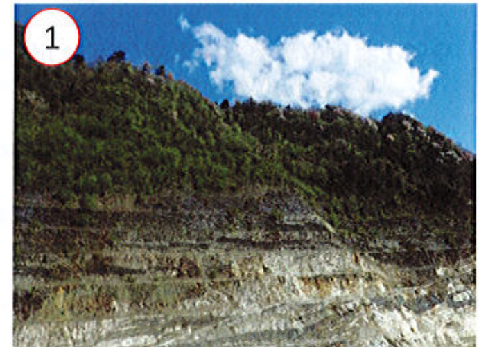
敷地内東側壁面を望む
