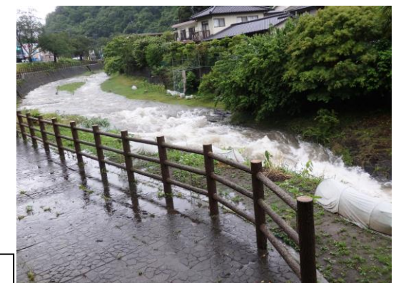
鮎川洪水3日後の写真 23/9/11 洪水当日は歩道溢水していた
