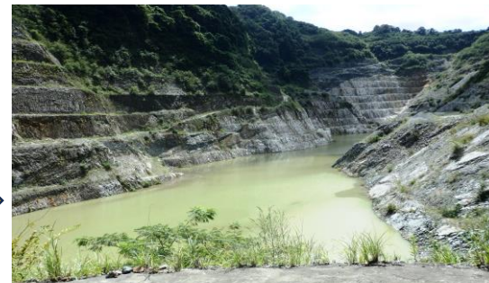
洪水翌日の唐津沢湖 23/9/9 豪雨土砂が流れ込み湖水変色、防災ダムの機能を果たした（湖面7～8m上昇）
