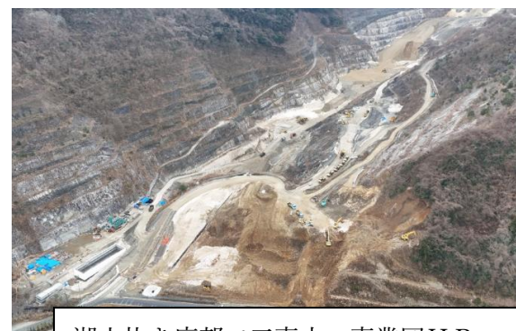
湖水抜き底部で工事中 事業団HP
