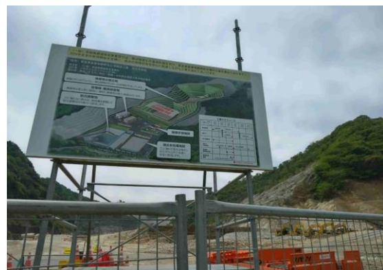
処分場工事で入口のブリ山が無くなり風景一変 25/5
