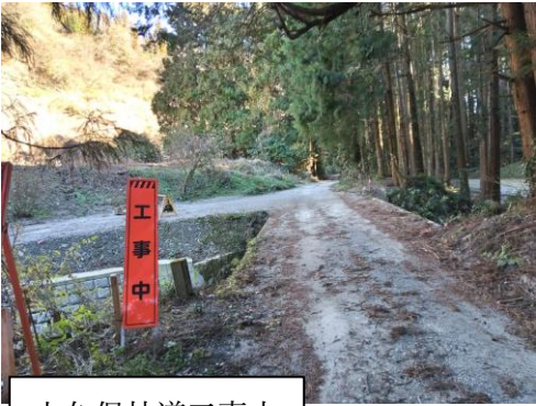
大久保林道工事中
