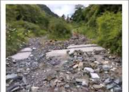
上流部洪水跡 9/12 12:05
