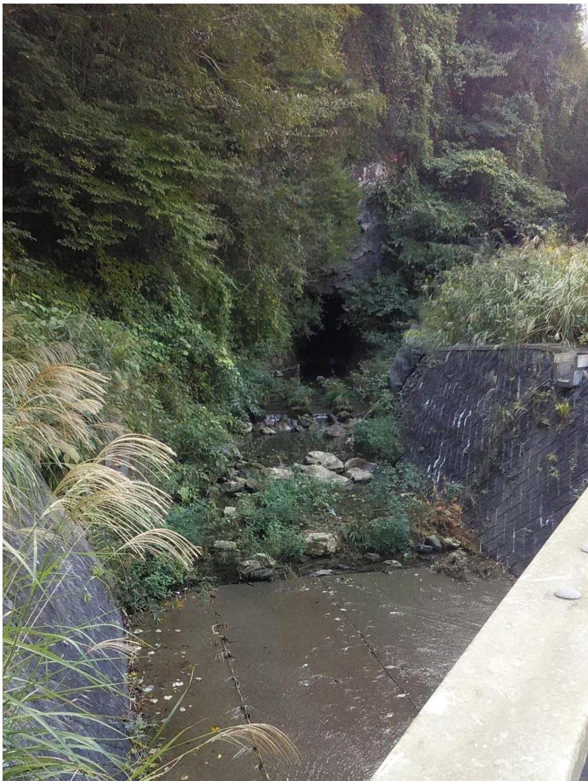
河川隧道（トンネル）の下流側出口の写真（出口直径：約 2 m 長さ；約 100m）
