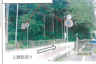
大型車通行止め表示板
