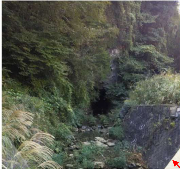
河川隧道（トンネル）の下流側出口の写真 (出口直径：約2m 長さ：約100m)
