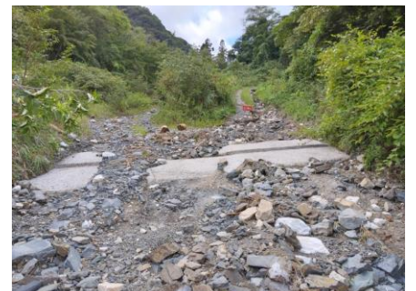
上流部洪水跡 9/12 12:05
